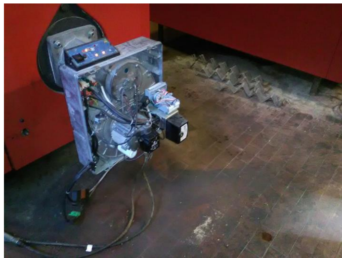
I bruciatori della caldaia di Andora privi di mascherine protettive, con cavi e parti elettriche a vista
