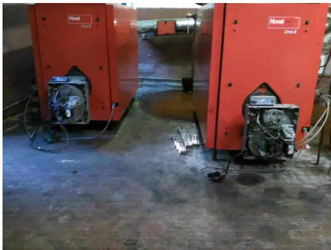
I bruciatori della caldaia di Andora privi di mascherine protettive, con cavi e parti elettriche a vista
